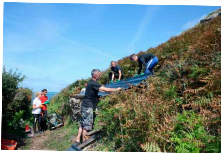
Chantier bénévole cabane de douane Auderville-SyMEL
