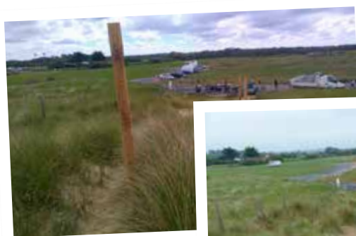
Pendant les travaux
