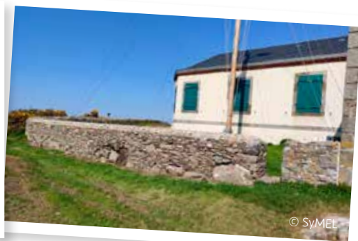
Mur rénové en mars 2020
