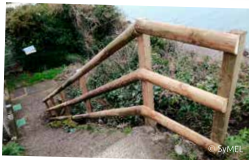
Rambarde de l'escalier d'accès au ponton d'embarquement
