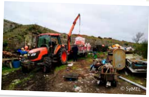
Chargement des encombrants stockés dans la cour du fort pour leur évacuation par la barge
