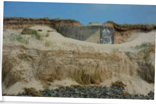
14/03/2016 Ouvrages du « Mur de l'Atlantique » et érosion marine Dunes de Saint-Rémy - Havre de Surville
