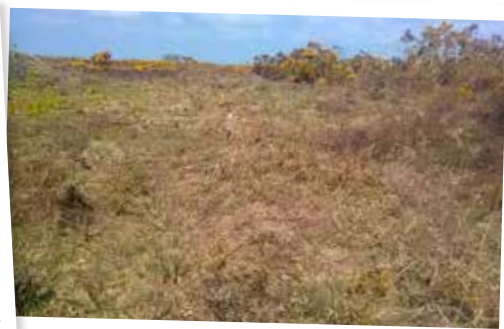
Travaux de broyage
