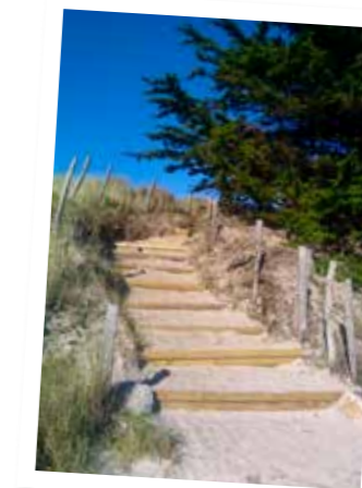
Escalier sud - état final
